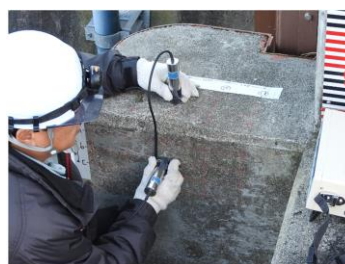
写真-2.1 超音波測定状況
