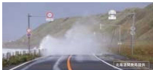
写真-1 沿岸道路における越波発生状況
