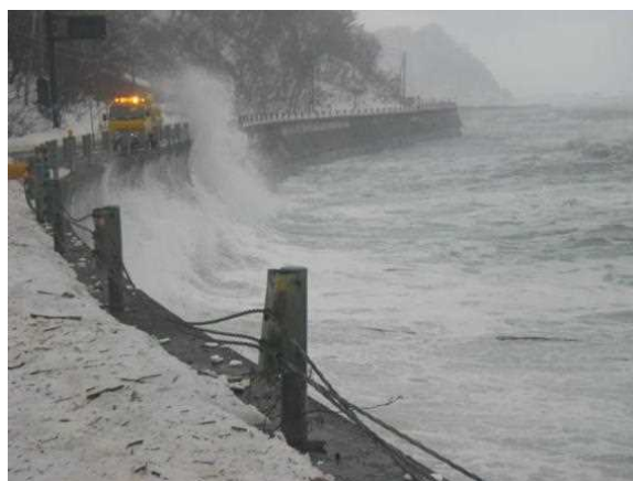
図-7 高波が海岸道路の護岸を越える様子 (北海道開発局小樽開発建設部提供)
