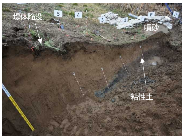
図 7-3 阿武隈川下流漏水発生箇所
