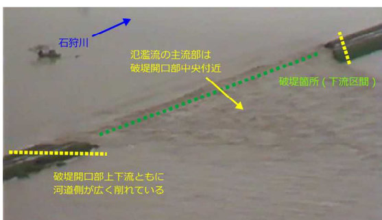
図-5 河道特性に応じて異なる堤防決壊現象 (上段: 石狩川水系空知川・下段: 石狩川)
