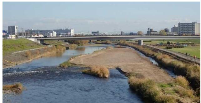
写真-2 掘削後の河道(東橋から下流側を望む)
