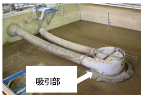
図-12 潜行吸引式排砂管 (φ300mm) の設置状況
