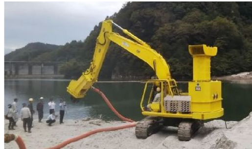
図-5 片桐ダム現場実験の状況
