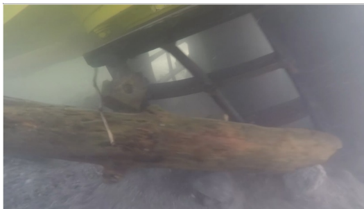
図-6 巨石、沈木の分別吸引状況
