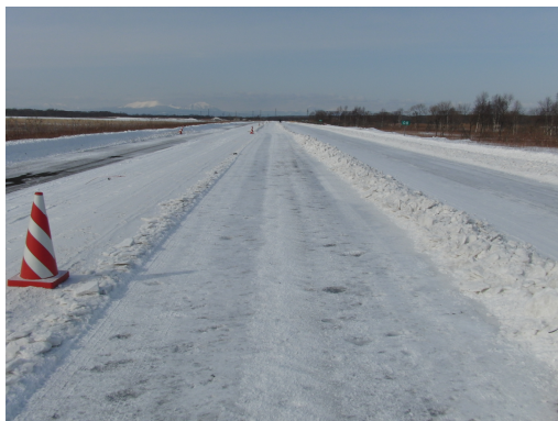
写真-9 試験区間状況
