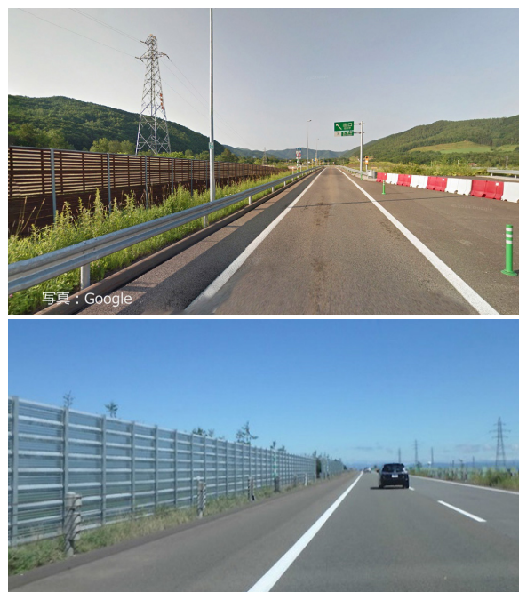
写真-1 北海道内の木製の防雪柵(上)と鋼製の防雪柵(下)
