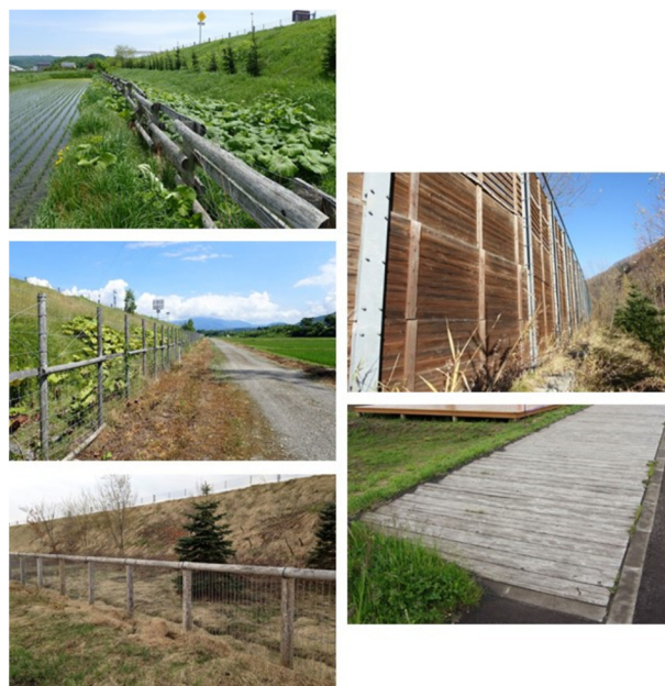
写真-2 調査対象とした木製工作物 (左列：立入防止柵、右上：防雪柵、右下：歩道舗装)
