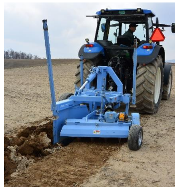
図-1 カットソイラーの施工状況
