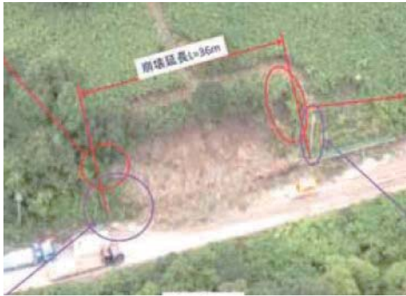
(a) 被災箇所状況
