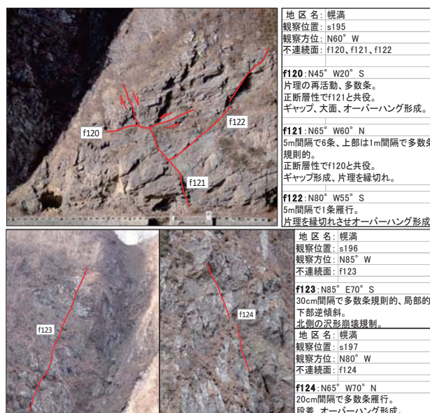
図-1 露頭で観察される亀裂の調査結果例
