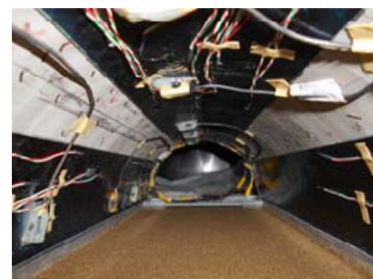
写真-9 補強状況
