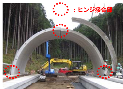
写真-1 施工時の3ヒンジアーチ
