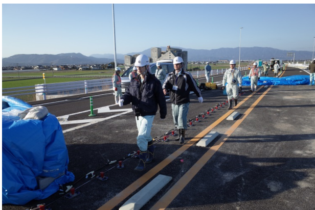
図-9 現場担当者との共同による計測調査風景
