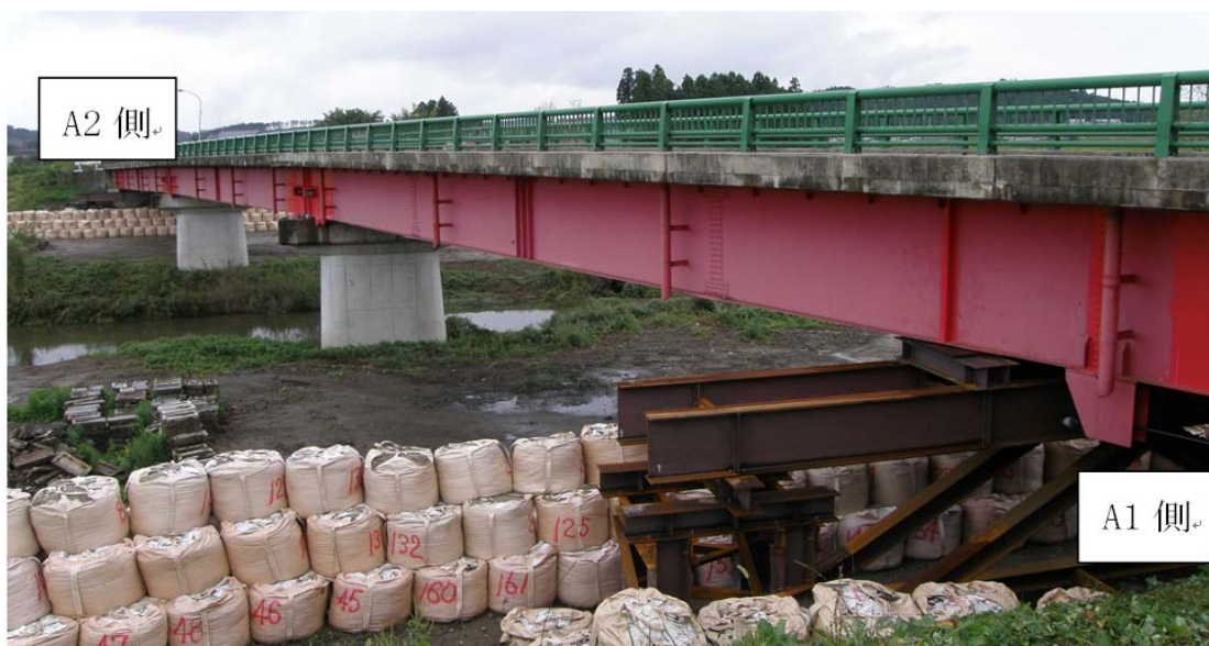
図-1 対象橋梁の様子
