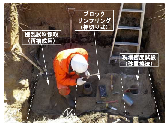
図-2.2 箇所 No.2 のブロックサンプリング状況 (同様の作業を隣接した3箇所でも実施)
