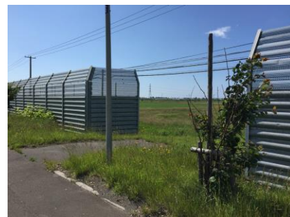
図 34 調査区間に設けられている副防雪柵
