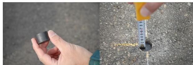
写真-12 磁気マーカ埋設状況
