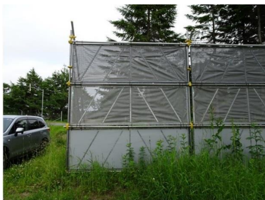
図 81 茶内防雪林で施工されているネット柵工
