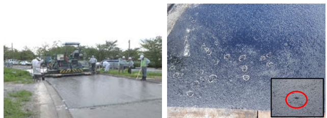
写真-12 開発グース施工状況
