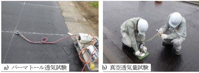
写真-15 透気試験状況
