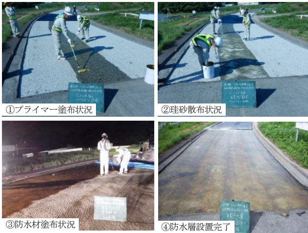
写真-14 開発防水層施工状況
