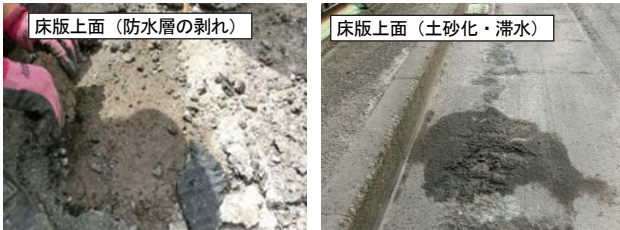
写真-3 C橋 目視調査結果
