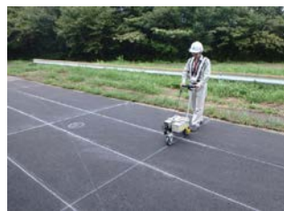
写真-17 わだち掘れ量測定状況
