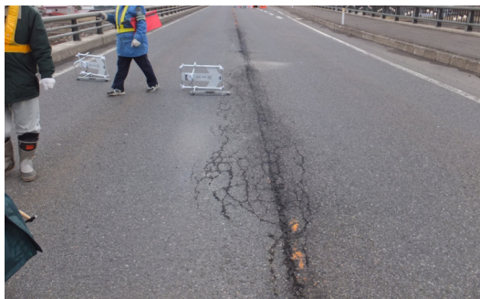
(b) 舗装を剥がす直前の状況、ただし撮影方向は逆向き
