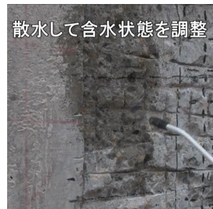
図-2.11 はつり面での含水状態の調整の例
