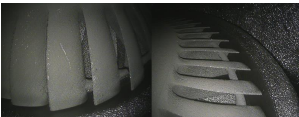
写真-3 過給器内撮影写真 (1号原動機 排気側タービン)
