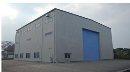
写真-3 設置環境の屋内で用いる倉庫
