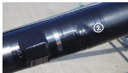
写真-8 温湿度計設置状況 (撤去ケーブル)
