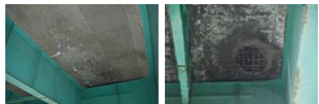
(a) 5年前の定期点検時
