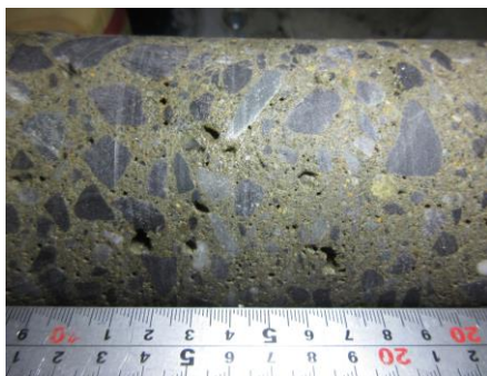
写真-2 締固め不足の供試体から採取したコア
