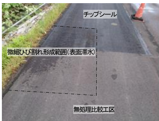
図5-4 舗装走行実験場内の試験工区
