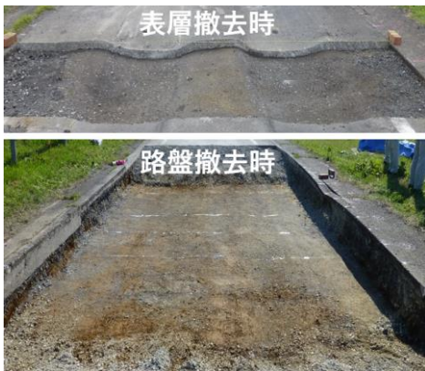
写真 2-2 開削調査時の舗装状況
