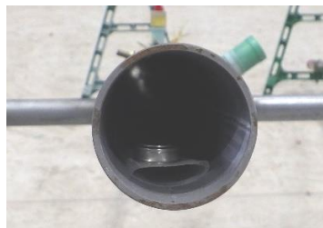
写真-1 ボタン型温湿度計の設置状況
