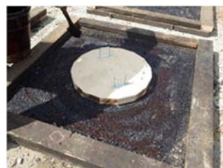
写真 3-2 模擬剥離部の円形木枠の設置
