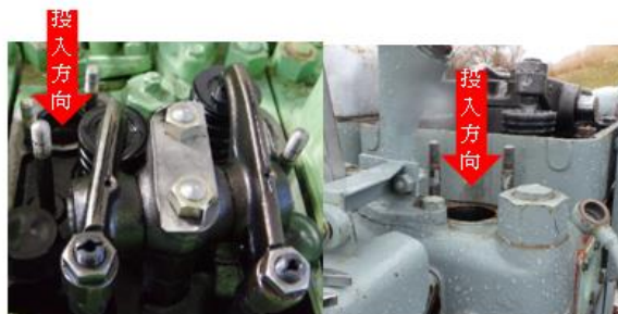
写真-8 内視鏡投入箇所 (左: B排水機場 右: S排水機場)
