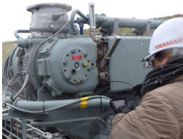
写真-1 内視鏡投入状況（1号原動機）
