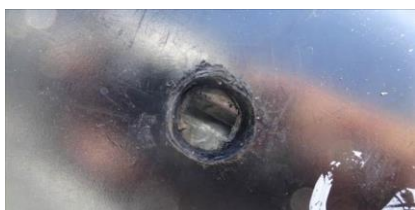
写真-7 削孔時の状況
