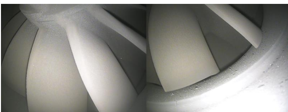
写真-4 過給器内撮影写真 (2号原動機 排気側タービン)
