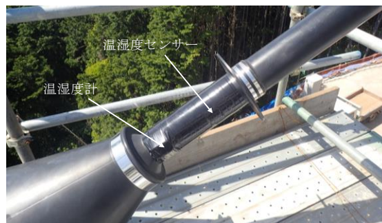
写真-11 温湿度計設置状況(実橋ケーブル)
