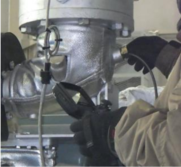
写真-2 内視鏡投入状況 (2号原動機)
