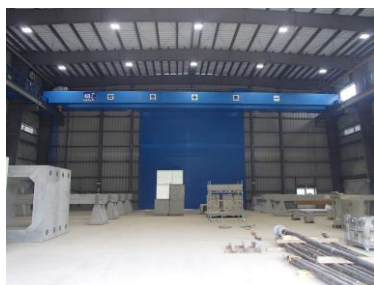
写真-4 設置環境の屋内で用いる倉庫の内部
