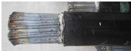
写真-5 撤去ケーブルの切断状態
