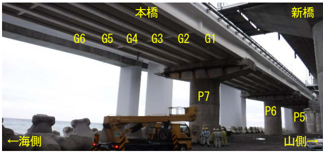
写真-1 橋梁外観 (写真は第6~8径間)
