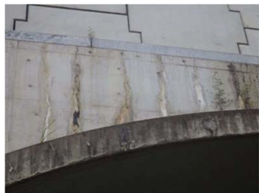
(b) ヒンジ式アーチカルバートウイングのひびわれの例
