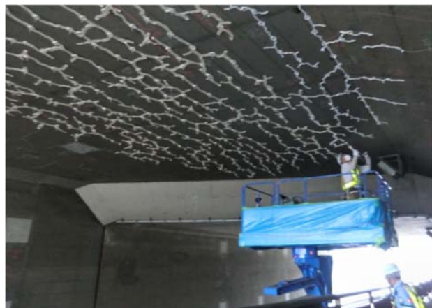
写真-2 ひびわれ補修の例
