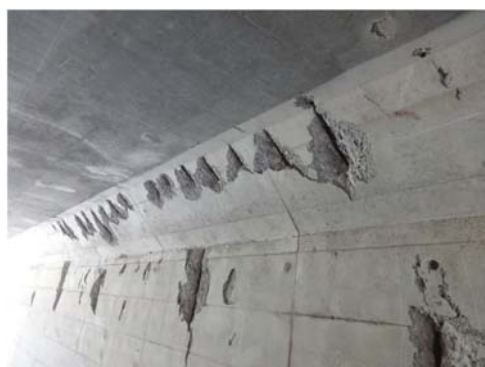
写真-6 うき・剥離のたたき落とし後の様子の例
