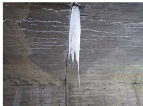
(d) 頂版継手部の氷柱
