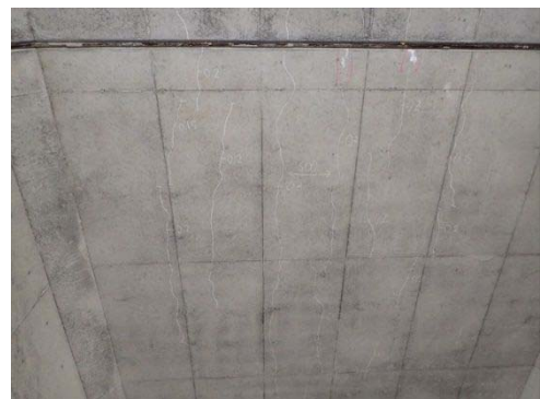
(a) 上載荷重によると考えられる軸方向ひびわれ (本写真は活荷重による例)
