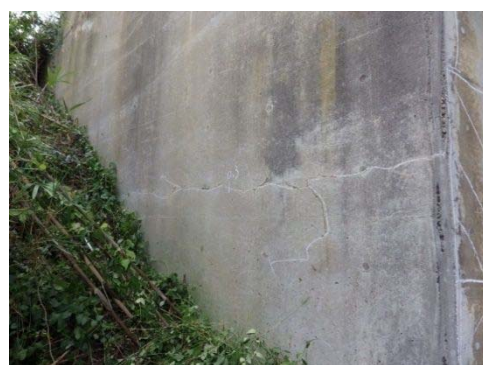
(b) 乾燥収縮によるひびわれ
