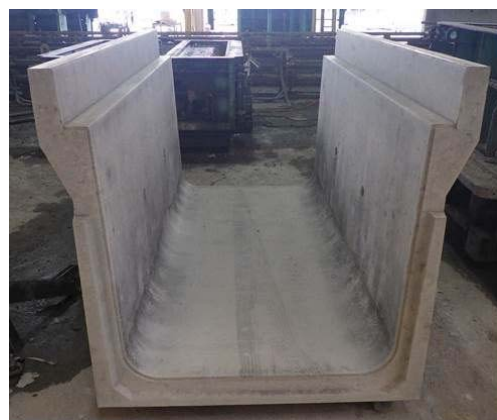
写真-2 水路内面ハンチ部の黒い変色事例
