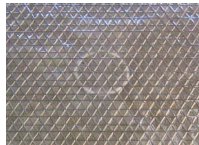
写真-2 網状シートの貼付け状況
