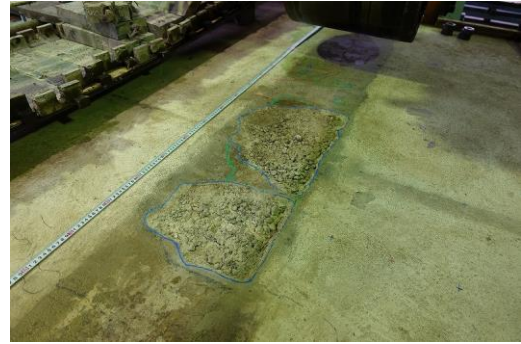
図-7.3 土砂化の状況 (S47 供試体, 26.5 万回時)
