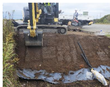
写真-4.2 試験施工状況
