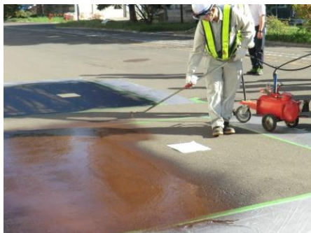
写真-3.1 寒地道路保全チームによる試験状況
