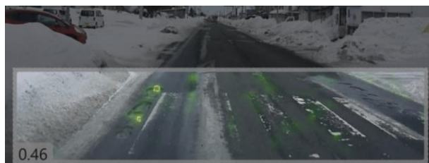
図-2.20 検出漏れの例(偽陰性、ポットホールを見落とし)
