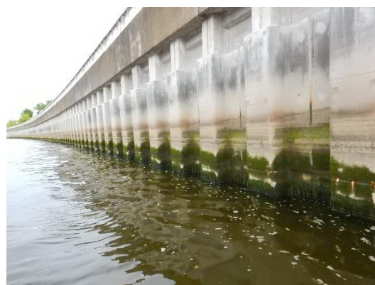
写真-2.7 高耐久型枠の取付区間の状況
