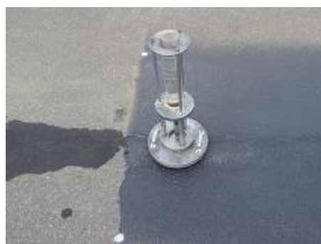
写真-3.4 現場透水試験による測定
