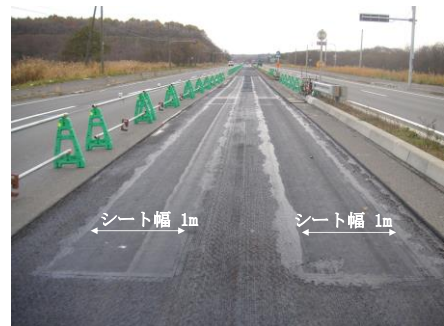
写真-2.2 ひび割れ抑制シート貼り付け後の状況
