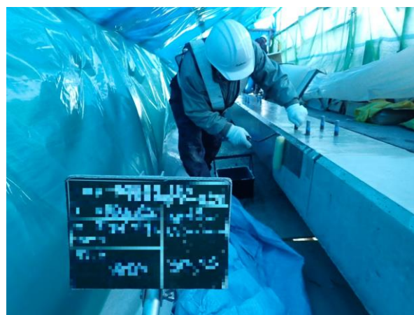
写真-1.1 厳冬期における防寒仮囲い内でのシラン塗布状況例（手前の黒板は画像処理を行っている）
