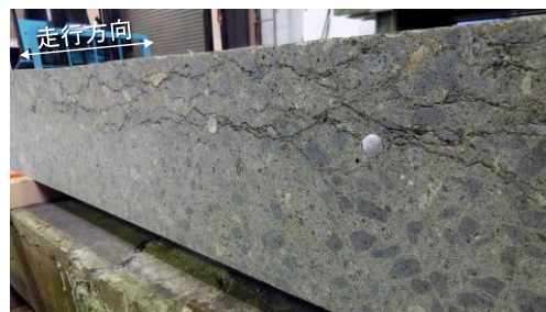
写真-12.1 切断面のひび割れ性状（D-D、試験終了後）
