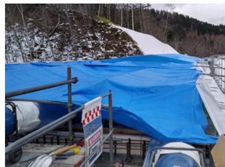
写真-4.1 養生状況
