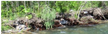
写真-9 高水敷上に繁茂するヤナギ (札内川上流部)
