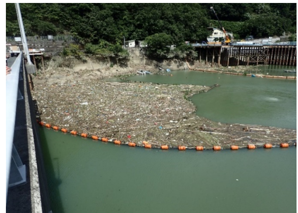
図-14 ダム堤体まで到達した塵芥等の状況
