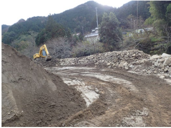
図-3 貯水池 5.0k の堆砂の分級作業の様子
