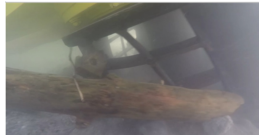
図-26 巨石、沈木の分別吸引状況
