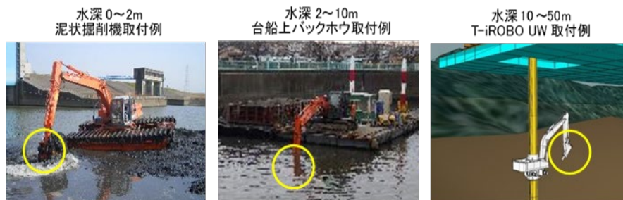
図-42 水深別前処理施工イメージ
