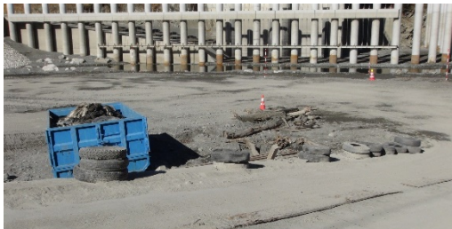
図-11 堆砂中に含まれていた流木等の状況
