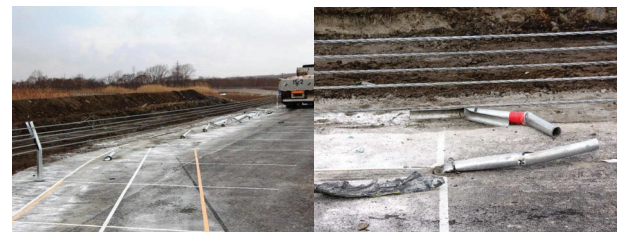
写真-36 性能確認試験後の状況 (平成28年3月)
