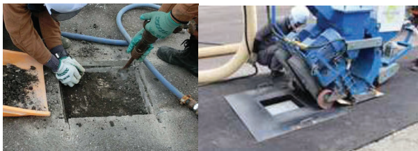
写真-19 舗装開削（左）と床版表面処理（右）
