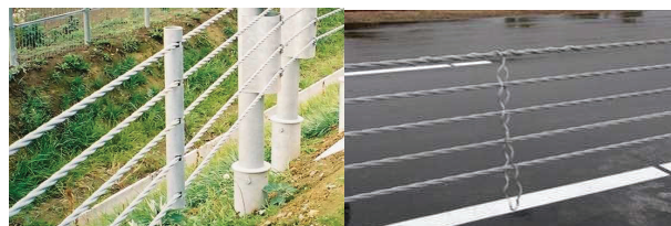
写真-35 間隔保持材（左）とロープ連結材（右）
