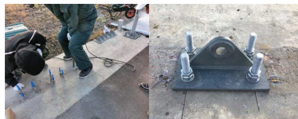
写真-28 端末金具施工状況
