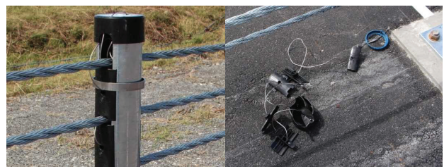
写真-49 回転式間隔材取付状況(左:衝突前、右:衝突後)
