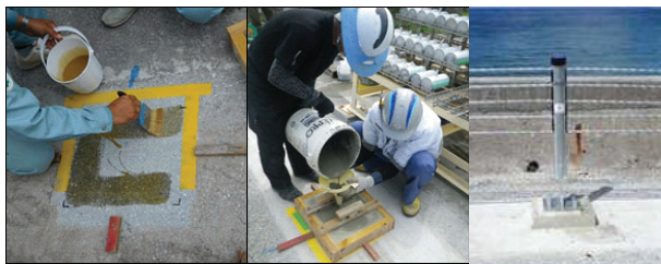
写真-17 支柱基礎コンクリート打設状況
