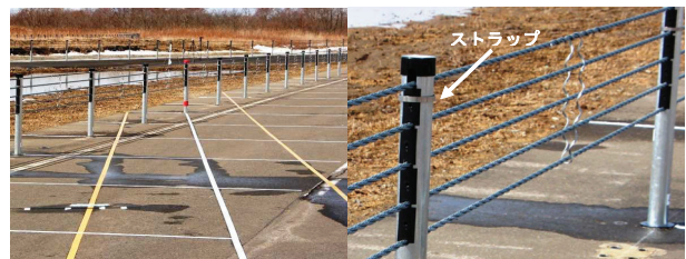
写真-38 防護柵(左: 中間支柱、右: 連結材とストラップ)
