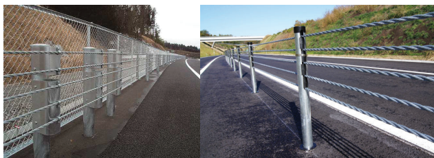
写真-3 ガードケーブル（左）とワイヤロープ式防護柵（右）
