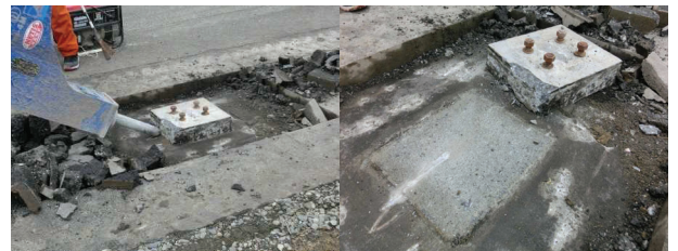
写真-24 基礎コンクリートの撤去
