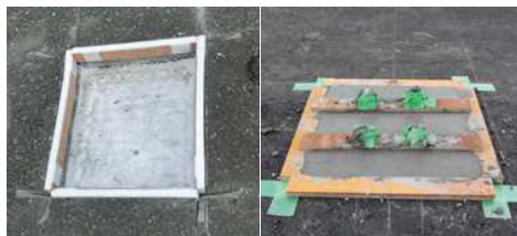
写真-20 接着剤塗布（左）とコンクリート打設（右）
