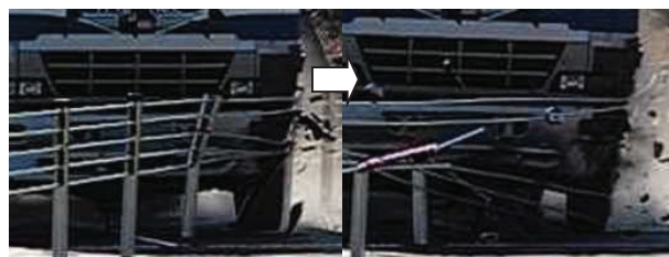
写真-34 大型車衝突時のワイヤロープ状況 1)
