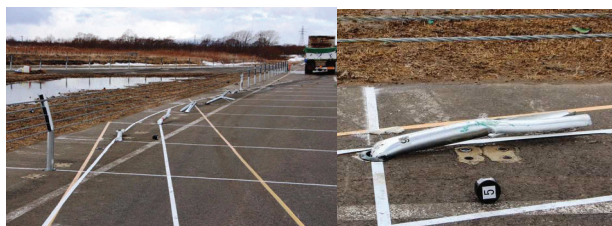
写真-43 性能確認試験後の状況(令和2年3月)
