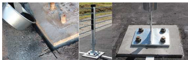
写真-21 防水材料施工（左）と既設橋梁用支柱建込み（右）
