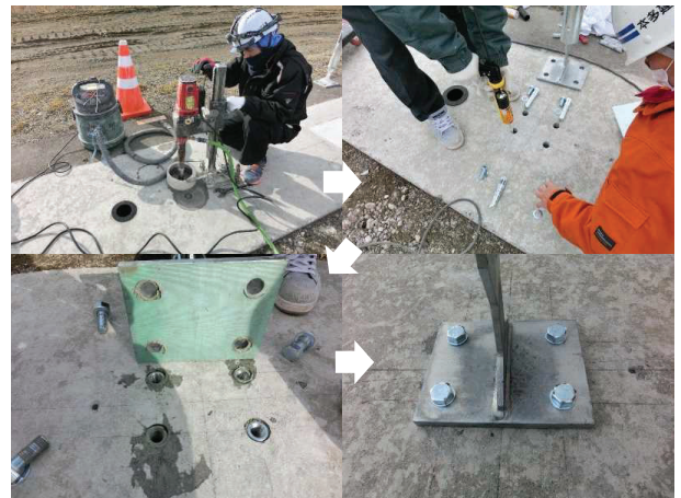
写真-31 接着系めねじアンカーの施工状況
