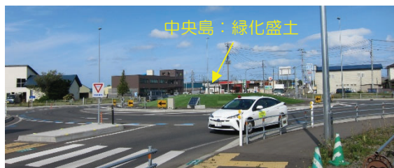
図-13 上ノ国ラウンドアバウトに仮設した中央島：緑化盛土
