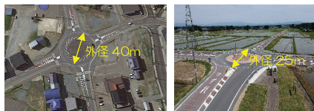
図-2 積雪寒冷地のラウンドアバウト (左：北海道上ノ国町、右：山形県長井市)
