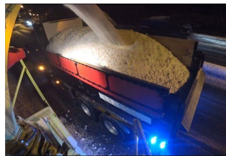
写真-16 積込状況撮影画像
