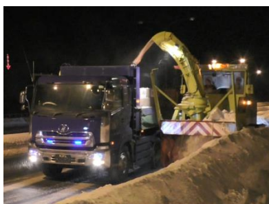
写真-15 作業状況
