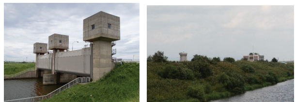
写真-20 設問 Q1 において亜鉛メッキの評価が高い構図 (左:ケース 9 水門、右: ケース 13 タンク) Ke-su
