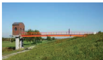
写真-9 厚別排水機場樋門。管理橋は 10R 5/14 で塗装されている
