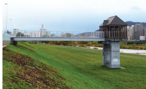
写真-11 管理桁の防止柵に2次製品を使用した樋門
