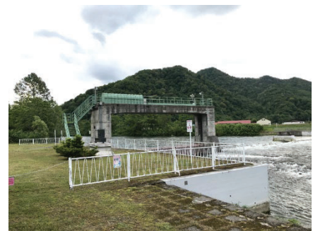
写真-13 東士別頭首工 (5.3G 6/2.8) 附属物も含めて色の統一が図られている
