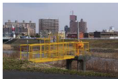
写真-10 札幌市管理の東橋公園樋門
