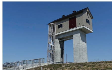
写真-3 ガイドラインに沿って建設された東の里排水門
