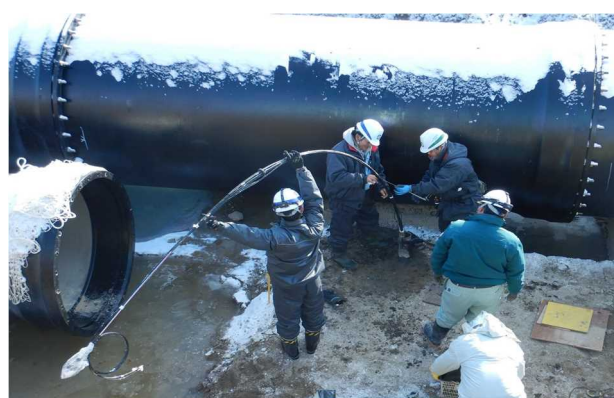
図-12 層別沈下計の設置の様子
