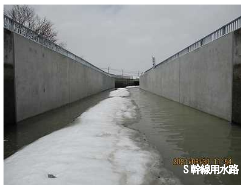
図-60 実証試験現場の状況
