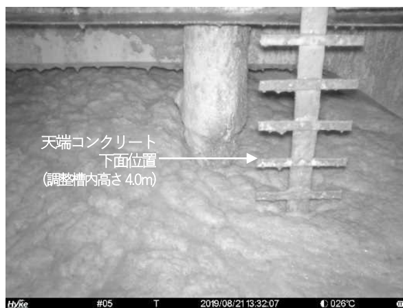
図-31 調整槽内部(2019/8/21 13:32)
