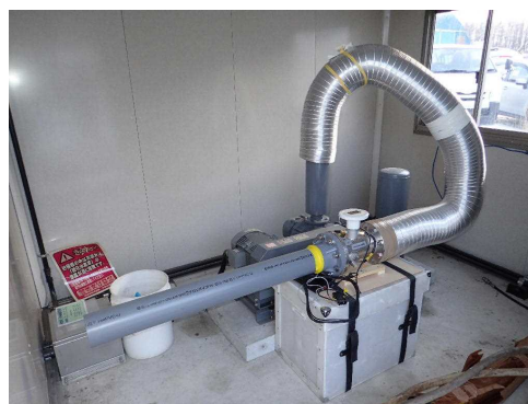
図-4 曝気ポンプの流量測定
