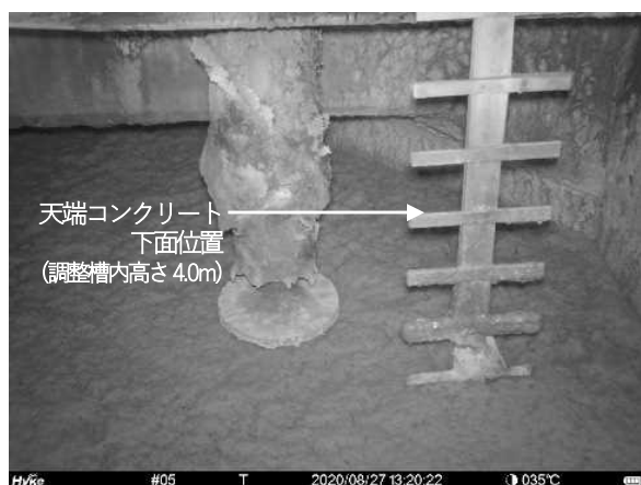
図-37 調整槽内部 (2020/8/27 13:20)
