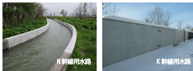
図-59 試験施工現場の状況
