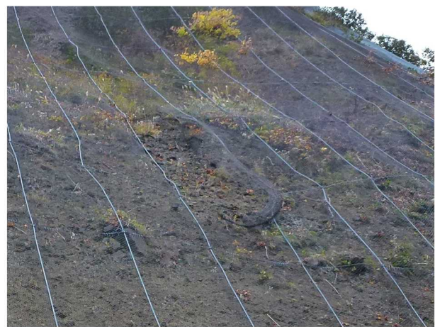
写真-1.2 覆式落石防護網のひし形金網の破網
