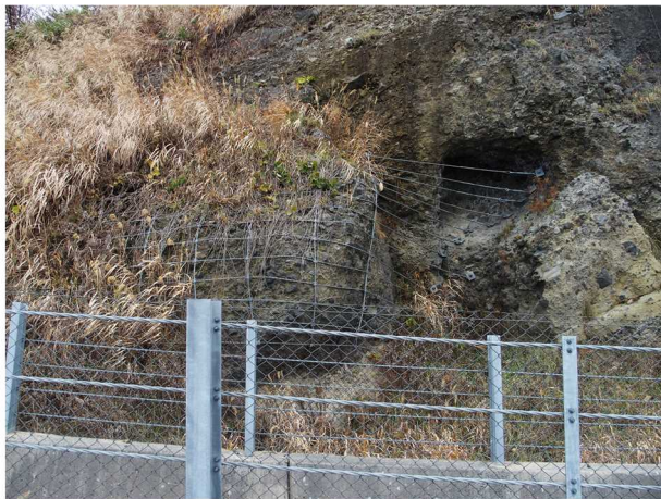
写真-1.3 ワイヤロープ掛工
