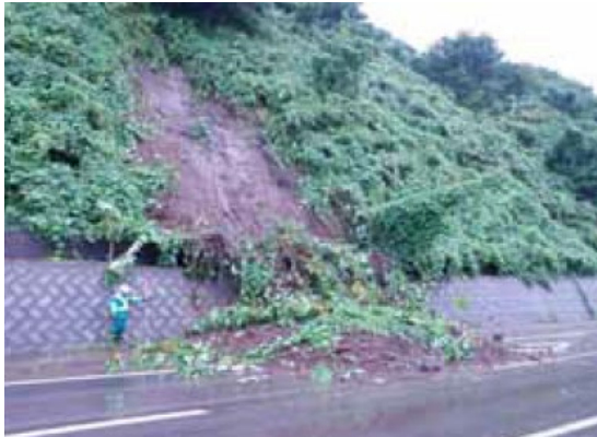
(a) 被災箇所状況
