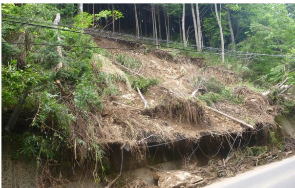
写真-1 表層崩壊の事例
