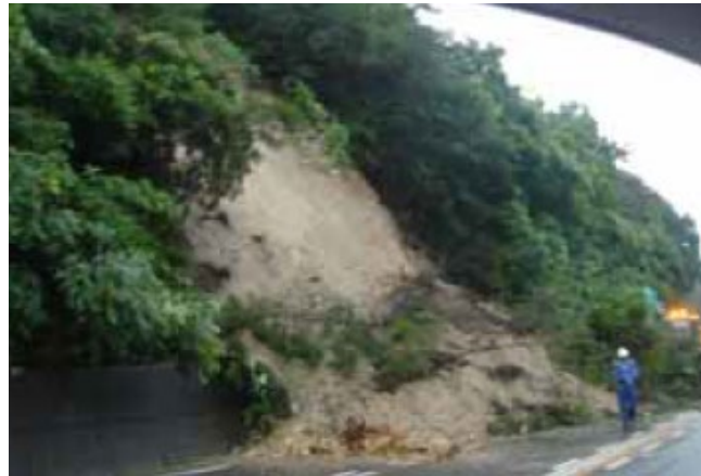
(a) 被災箇所の状況
