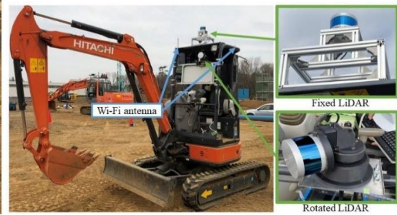
図-6 SLAMシステムを搭載遠隔操作型油圧ショベル
