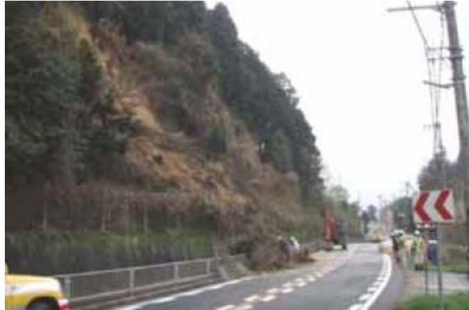
(a) 被災箇所の状況
