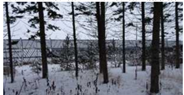
図 107 風上側林縁の防風ネット柵(KP66.470～66.590)
