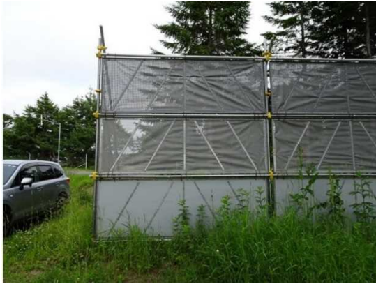
図 98 茶内防雪林で施工されているネット柵工
