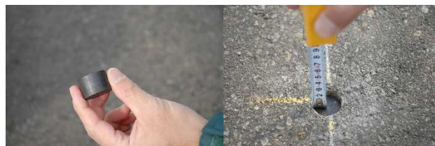
写真-12 磁気マーカ埋設状況
