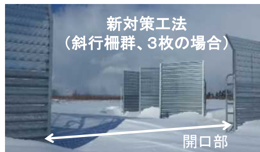
図 41 開口部における斜行柵群の設置状況
