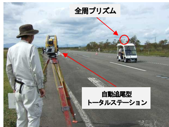
写真-10 TSによる計測状況 (直線部)
