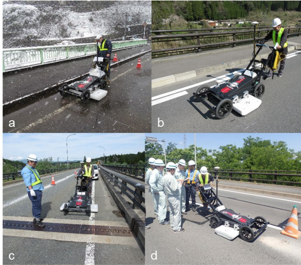
図 2 GPR 調査の様子
