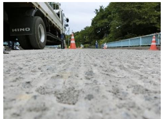
写真-6 既設床版の舗装切削状況
