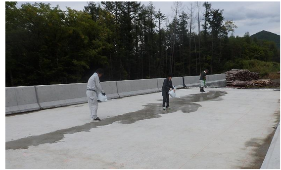
写真-1 散水試験の状況
