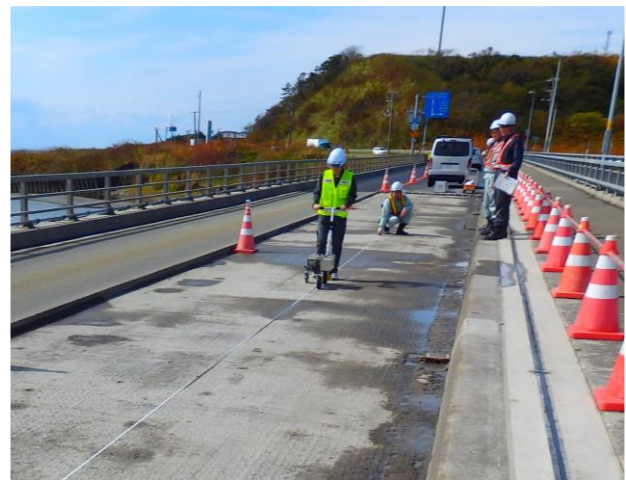
写真-3 床版面形状の測定状況
