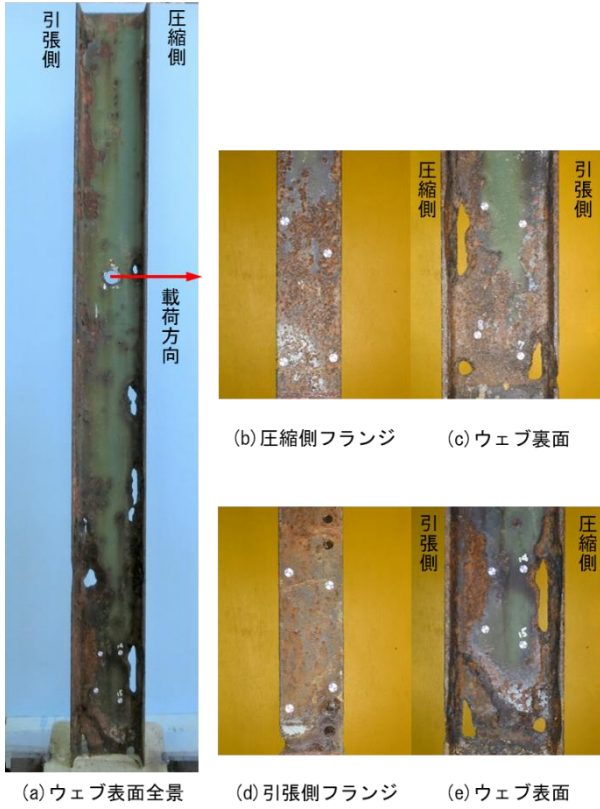
写真-18 試験体の外観状況 (劣化材 4)
