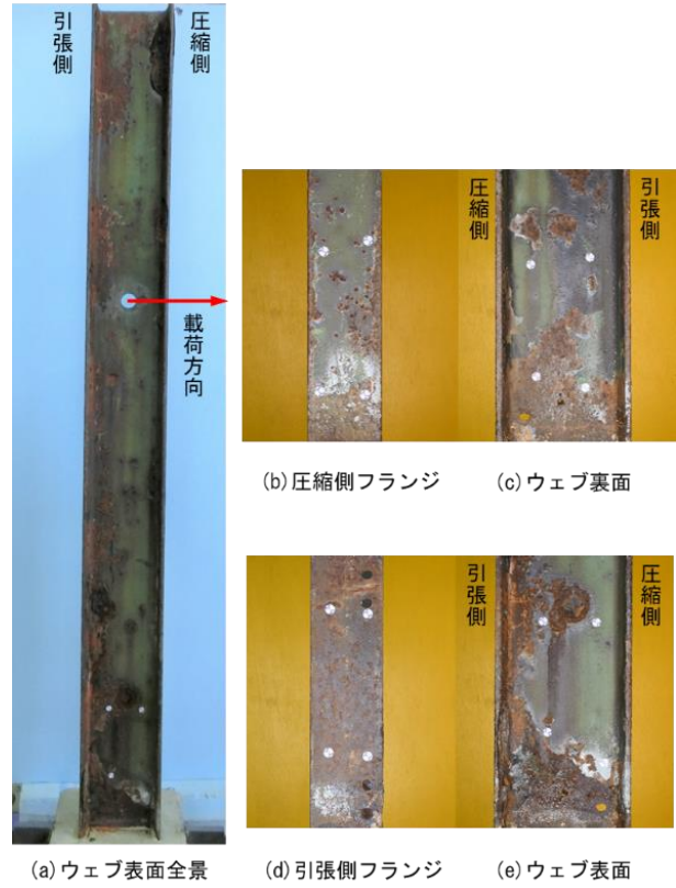
写真-15 試験体の外観状況（劣化材 1）
