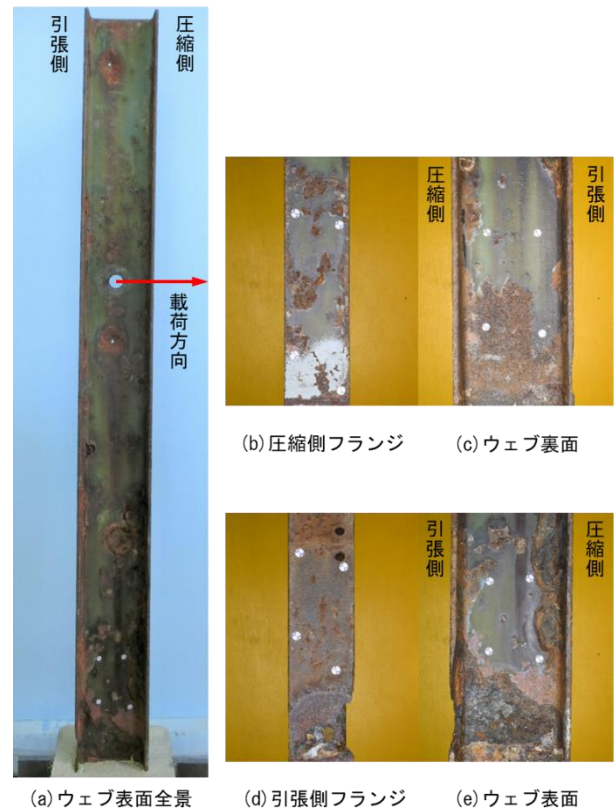
写真-17 試験体の外観状況（劣化材 3）
