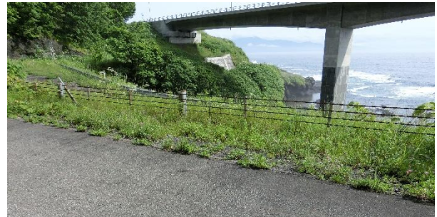
写真-3 試験材料採取箇所（ケーブル型防護柵）
