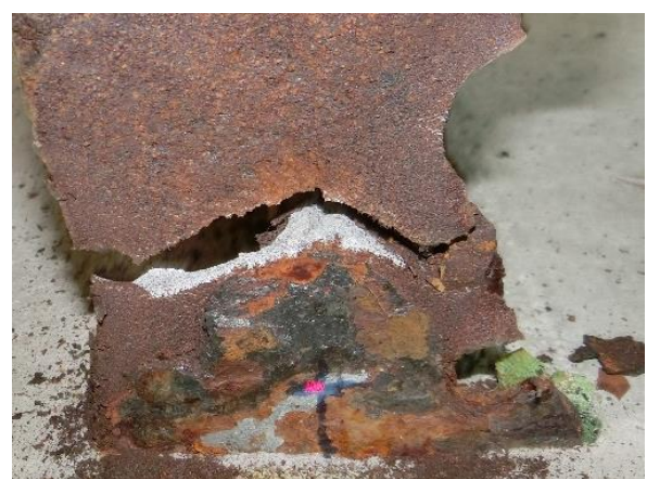
図-22 劣化材3のフランジの腐食と載荷前後の状況
