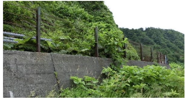
写真-2 試験材料採取箇所（落石防護柵）
