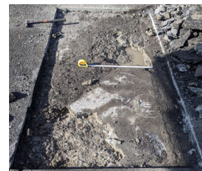
写真-4 部分開削部の床版面状況
