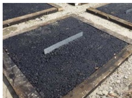
写真-2 模擬ひび割れ作成
