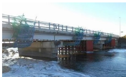
写真-1 対象橋梁全景
