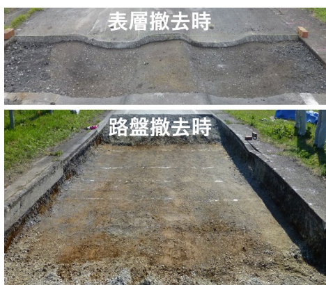
写真-2 開削調査時の舗装状況
