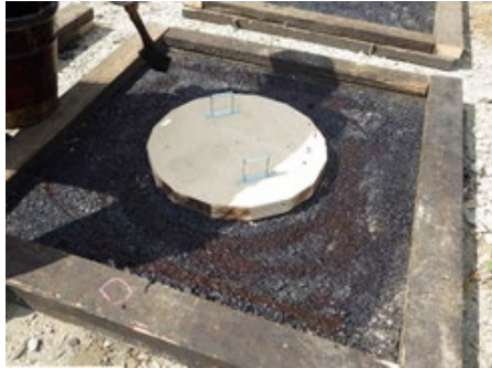
写真-3 模擬剥離部の円形木枠の設置
