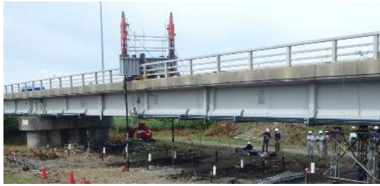
写真-1 本橋全景 (実橋載荷試験実施時)
