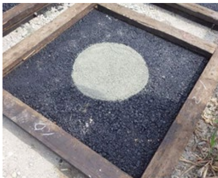
写真-4 模擬層間剥離作成
