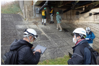
写真-1 RC床板の実証状況（鳴瀬大橋）
