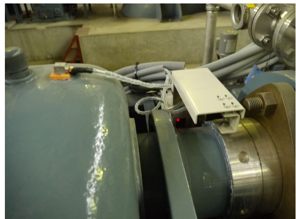
写真-7 横軸ポンプ用計測治具による計測
