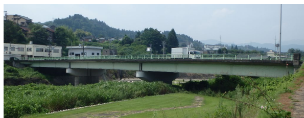
写真-5 A橋全景
