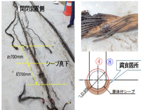
写真-4 ワイヤロープ損傷状況
