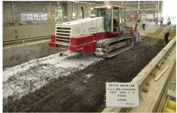
写真 2.1.2 路床の石灰混合状況
