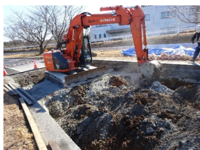
写真 2.3.1 セメント系固化材の混合
