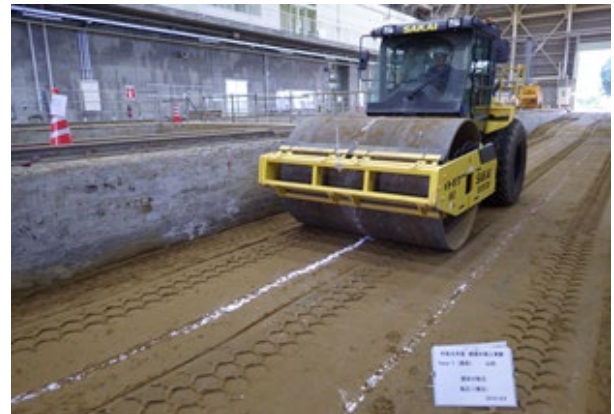
写真 2.1.3 路床の転圧状況
