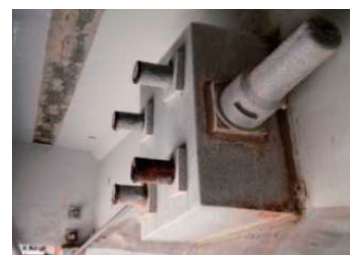
写真-1 PC 桁の外ケーブル定着構造
