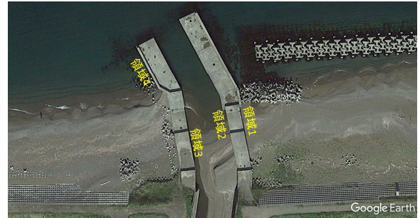
図 - 3 上空から見た A 導流堤
