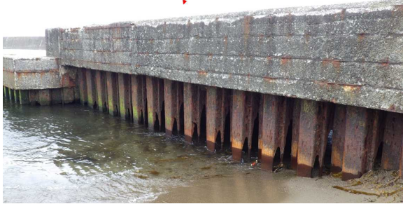
図 - 5 A 導流堤（領域 2）の劣化状況
