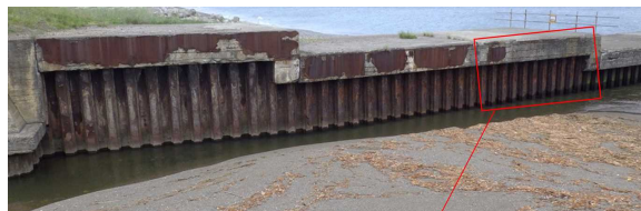
図 - 5 A 導流堤（領域 2）の劣化状況
