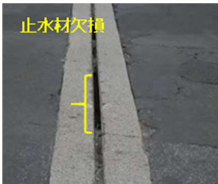
図-1 橋梁ジョイント止水材設置例
