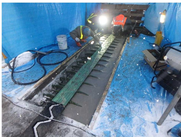
写真-13 冬期施工時のシート養生
