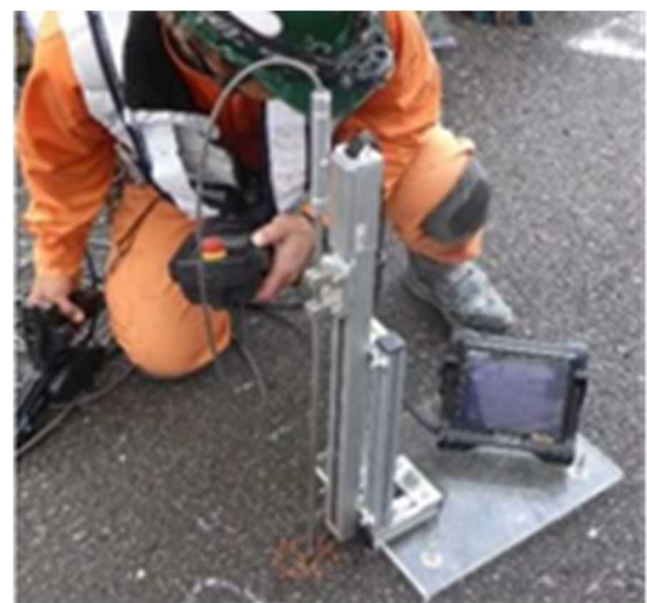
写真-9 小径コア内部撮影状況
