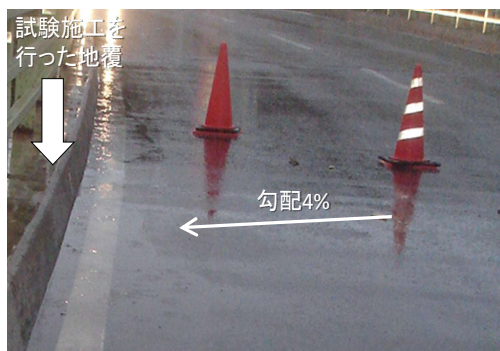
写真-1.1 雨天時の美幌橋の様子
