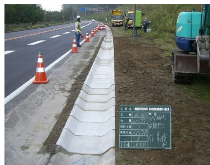
写真-3.1 皿形側溝製品の敷設状況 (6合目付近)
