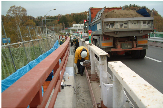
写真-1.2 試験施工の状況 (2004年10月28日)
