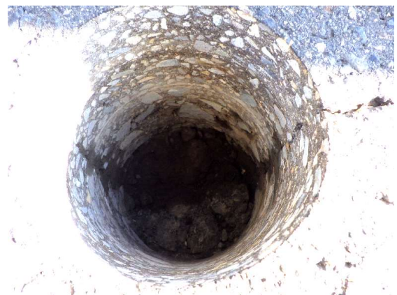
写真-3.6 コア採取孔の状況
