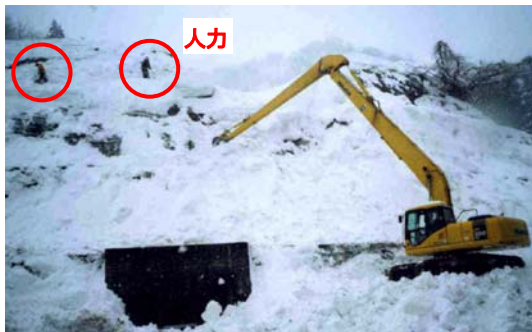
図-6 道路路面(モルタル吹きつけ斜面)の着雪除去
