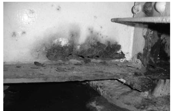
図-1 鋼橋桁端部の腐食例
