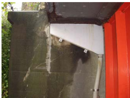
図-14 簡易排水装置の設置状況
