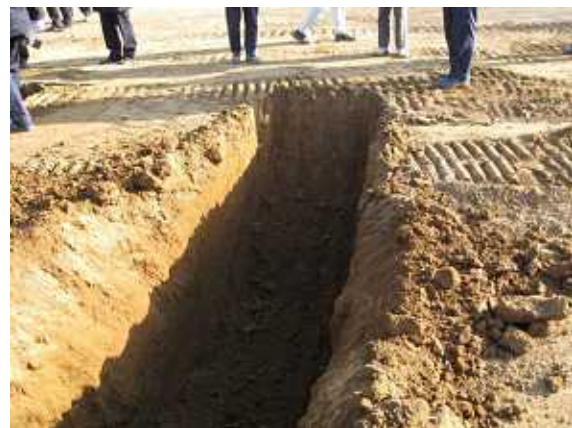
図-15 自動掘削作業終了後の出来形
