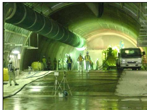
写真4 伸縮風管による粉じん低減技術
