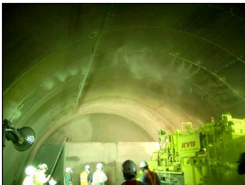
写真6 伸縮風管とミストによる粉じん低減技術
