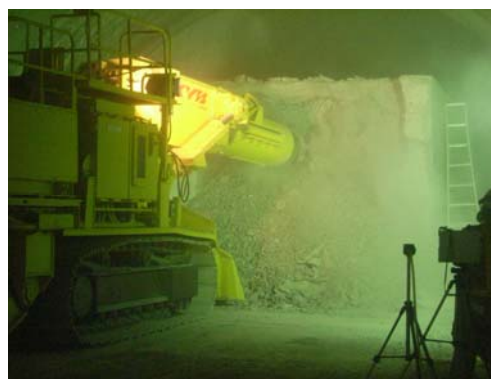
写真1 模擬岩盤コンクリート掘削状況
