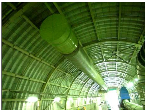
写真5 伸縮風管+エアカーテンによる粉じん低減技術
