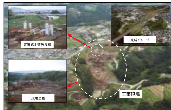
図6 伊豆縦貫道-塚原 IC の工事の様子
