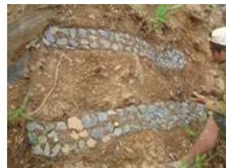
写真-4 ストンマルチ工の状況
