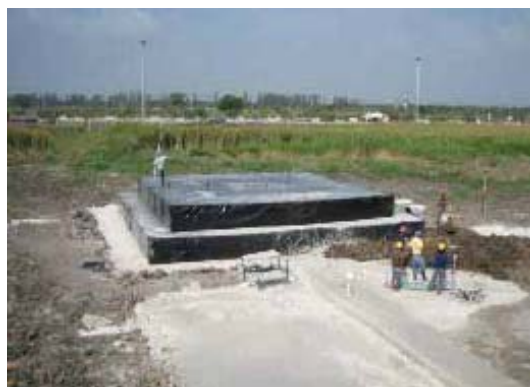
写真-1 試験盛土の様子
