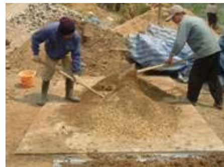
写真-3 種子・表土・土壌改良材(籾殻)の混合
