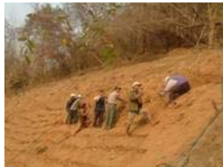
写真-2 溝切りと混合土の埋め戻し
