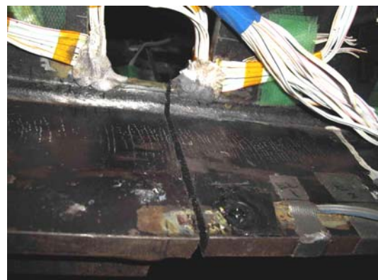
写真-4 フランジ切断
