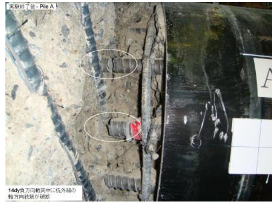
写真-3.2 杭軸方向鉄筋破断状況 (Case 1)
