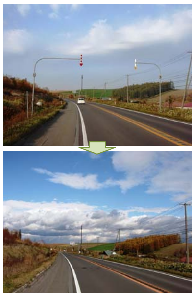
写真-4.2 固定式視線誘導柱の適正化事例
