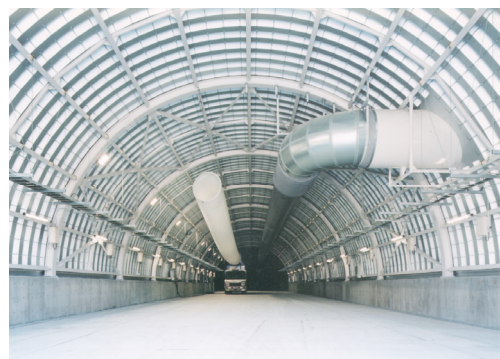
写真 2 実験施設内部
