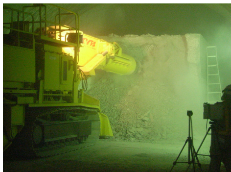
写真3 模擬岩盤コンクリート掘削状況
