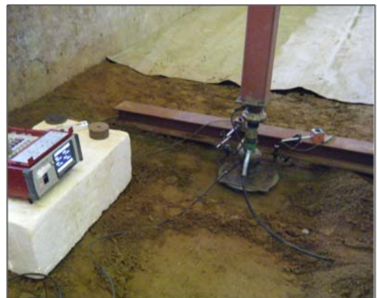
写真-10 平板載荷試験状況
